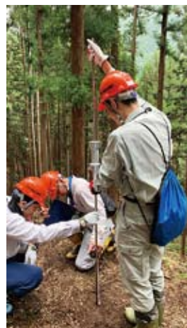
路体構造調査 (簡易動的コーン貫入試験の実施)
