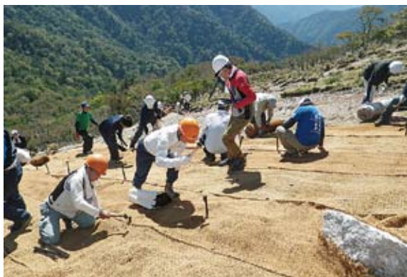
マット設置作業
