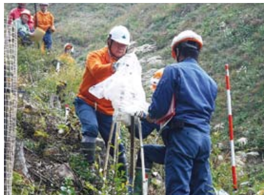
生分解資材による苗木防護柵設置実演
