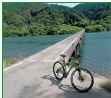
四万十川 三里橋 (三里沈下橋)
