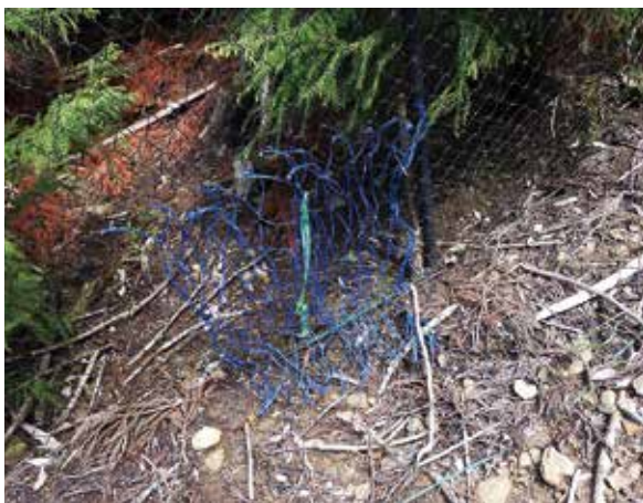
当て布方式で補修された防護柵
