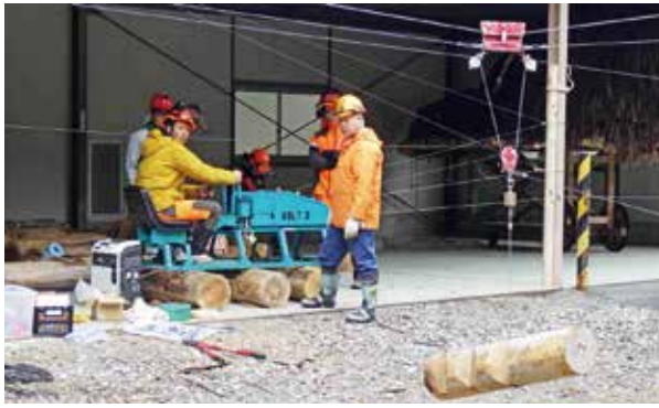
集材作業の様子
