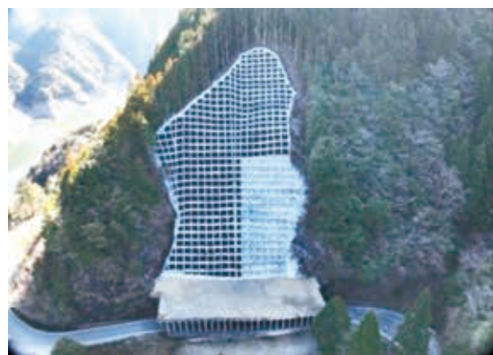
復旧治山工事
