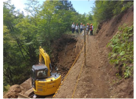
林道工事の現地説明
