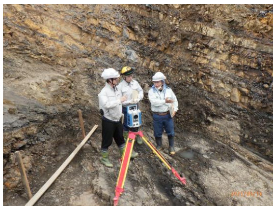
林道復旧工事説明
