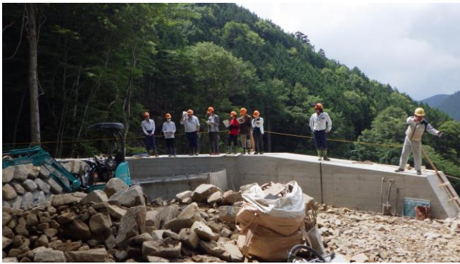
治山工事の現地説明
