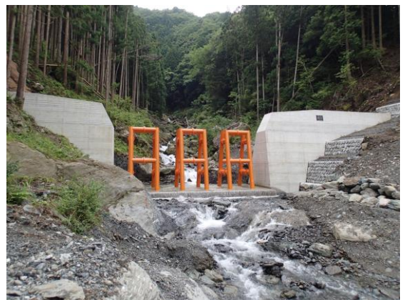
復旧治山工事
