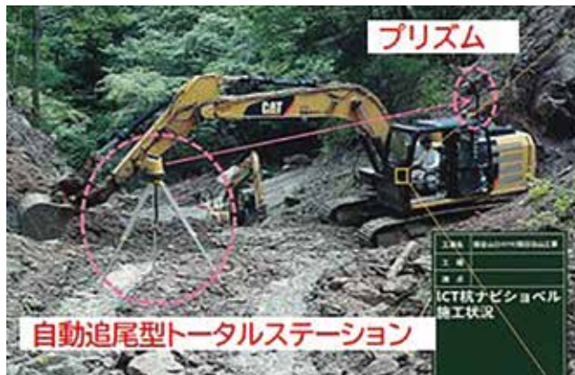
ICT施工の様子
