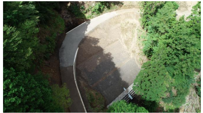
西又東又林道災害復旧工事
