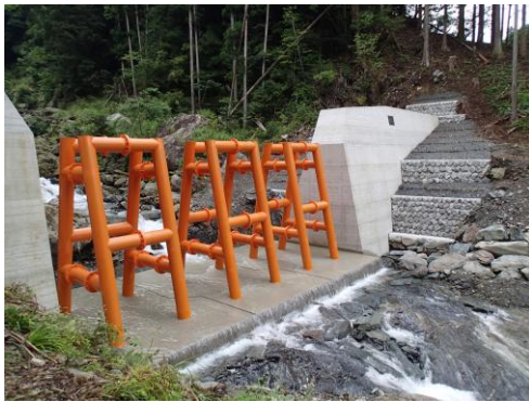
吉野川上流地区仁尾ヶ内（上） 復旧治山工事
