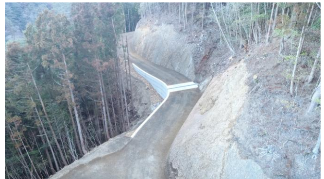
長滝林業専用道新設工事
