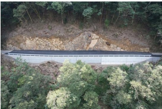
奥藤林道改良工事
