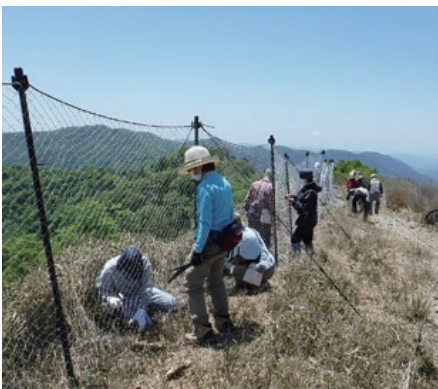
ボランティアによるシカ食害防護ネットを設置している様子
