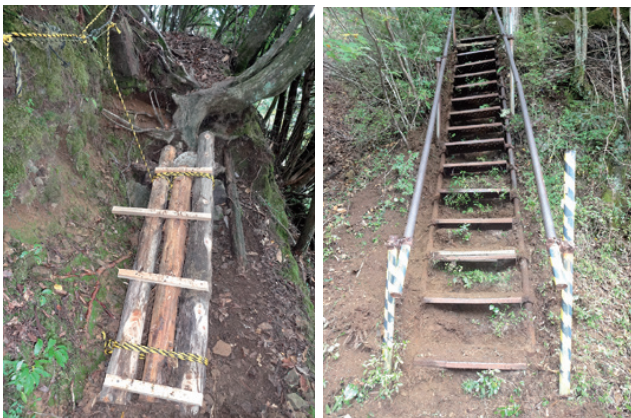
補修作業後の状況
