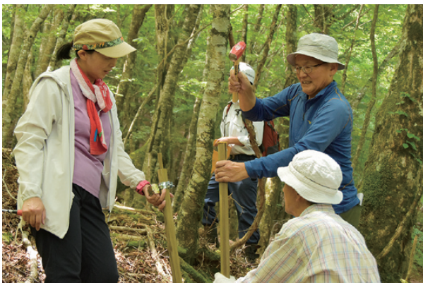
シカ柵の杭をハンマーで打ち込み
