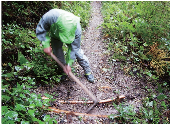
登山道の修繕の様子
