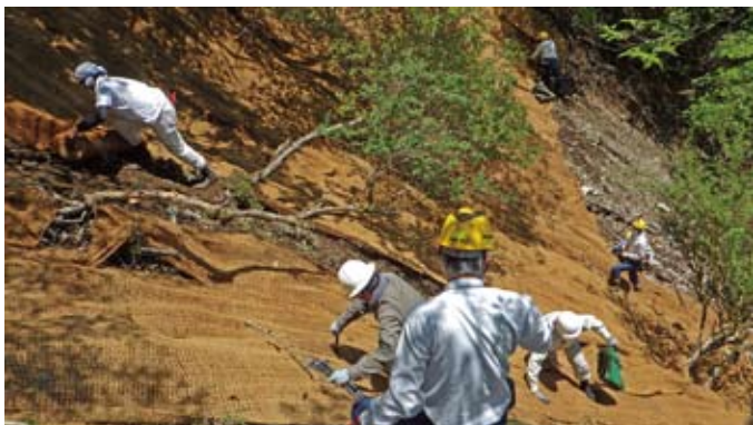
土砂流出防止マット設置と補修作業の様子
