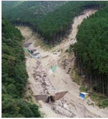
奈半利川地区民有林直轄 治山事業箇所（北川村平鍋）
