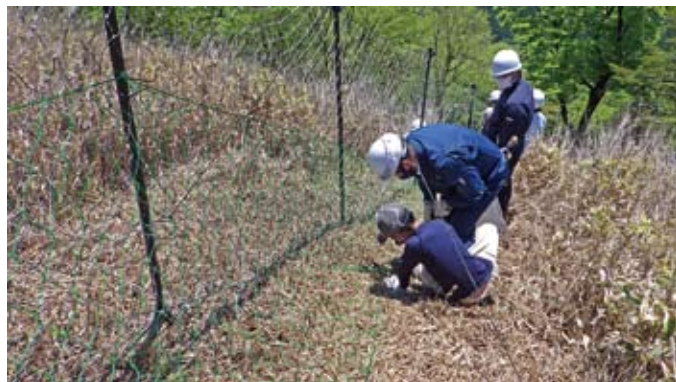
シカ食害防護ネットの設置作業の様子
