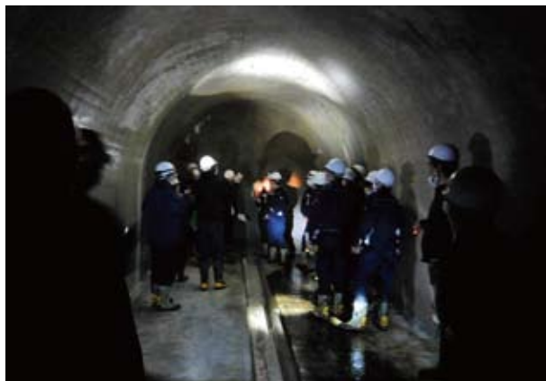
既設排水トンネルの説明
