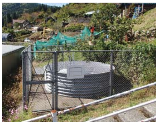
集落内に施工した集水井工
