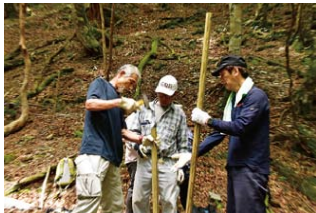
防止柵の外周に支柱を打ち込んでいきます
