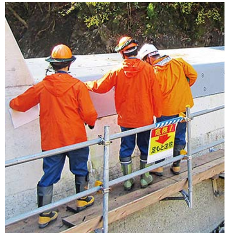
現場実習の様子
