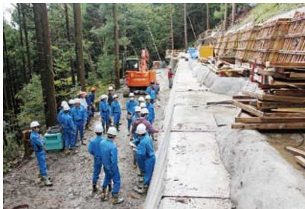
アンカー工の見学
