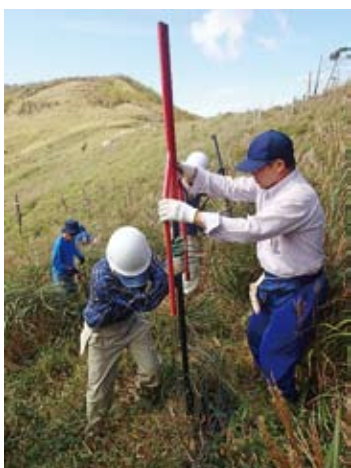
支柱交換の様子
