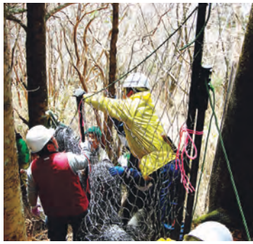
防護柵の設置
