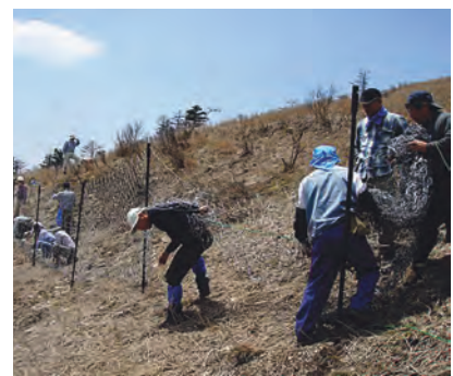
ボランティアによる防護柵の設置
