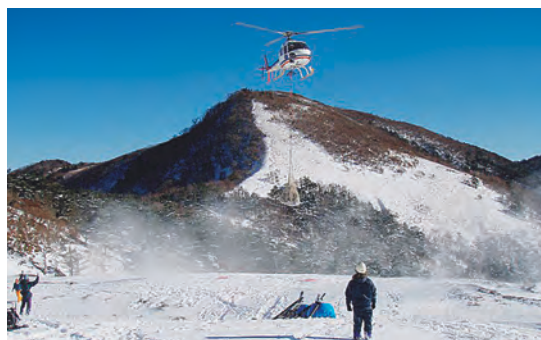
ヘリコプターによる資材運搬の様子
