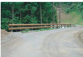
間伐材を利用した木製ガードレール
