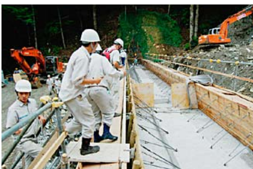
木製残存型枠を使用した治山ダムをチェック
