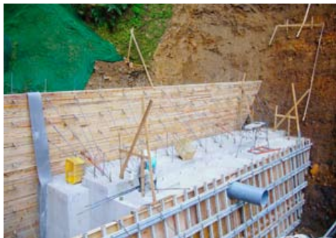
愛媛県 (木製残存型枠)
