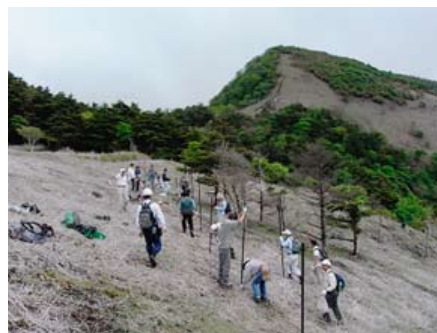
八班に分かれての防護柵設置作業
