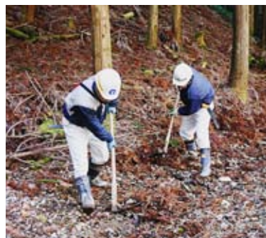
歩道整備の様子
