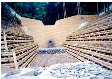
残存型桧治山ダム工
