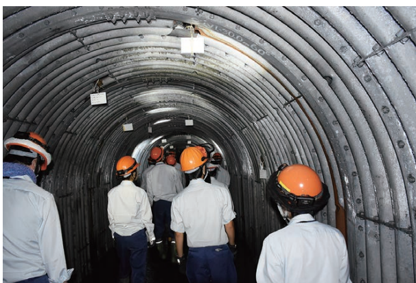
排水トンネル工見学
