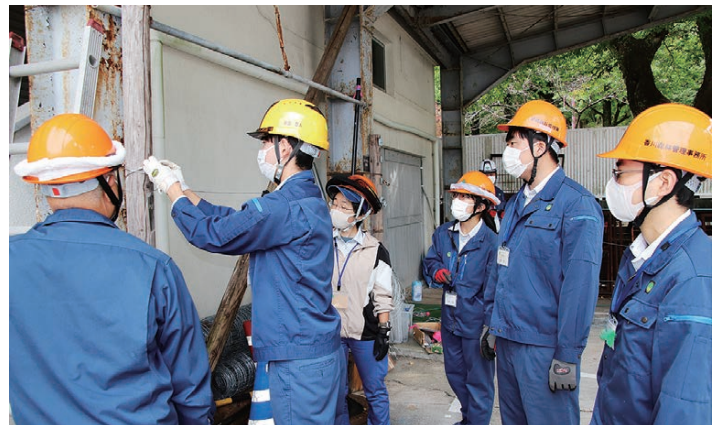
架設作業の様子
