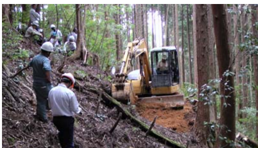
作業路の作設実習を行う参加者
