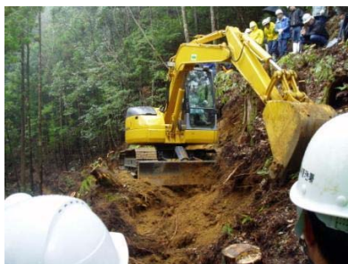
低コストで壊れにくい作業道作設研修の様子
