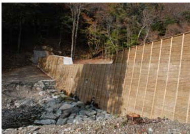
存置型 型枠を使用した治山ダム工
