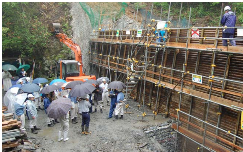
治山工事（溪間工）現場での様子
