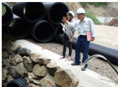
林道新設工事箇所の説明
