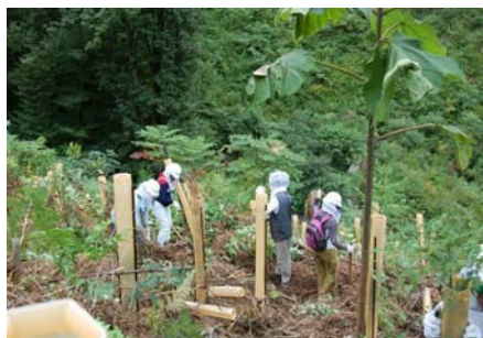
保護チューブ修理作業
