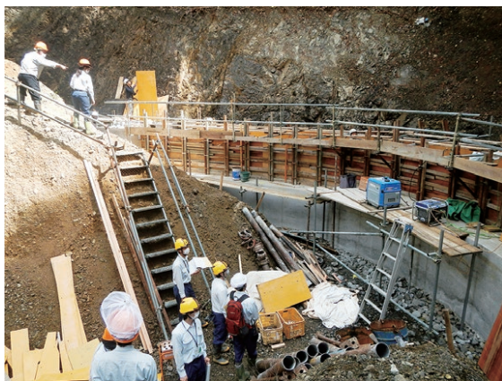
林業災害復旧工事現場の様子
