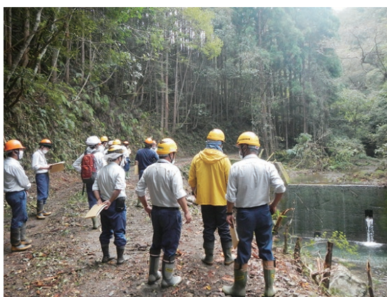
林道災害箇所の様子
