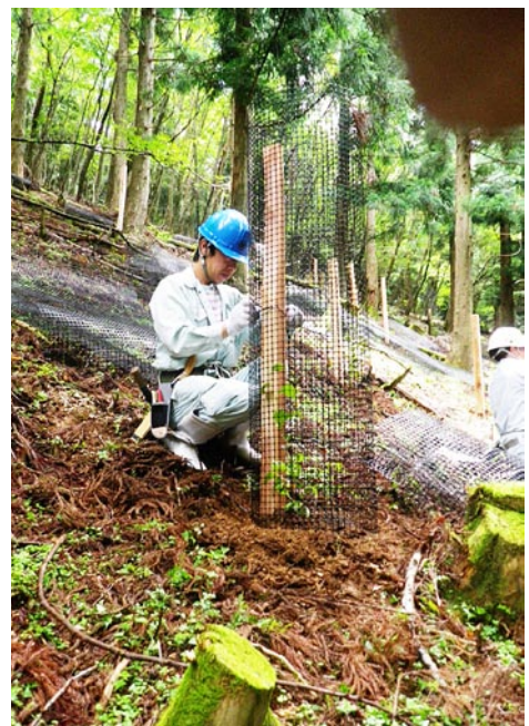
樹木ガード取付中
