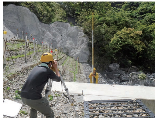
治山事業箇所でのレベル測量
