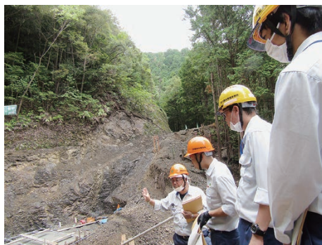
引地林道補修工事の様子
