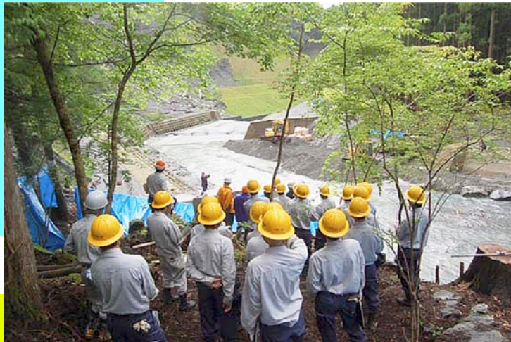
治山工事の現場
