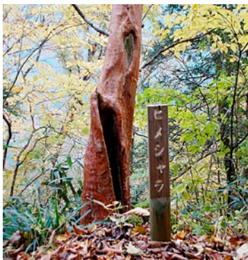
補修・整備後の樹名標杭
