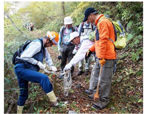
樹名標杭を補修中
