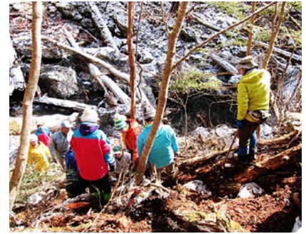
土のうによる階段作り
