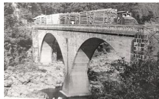
二股橋(昭和15年完成。資材不足のため鉄筋を使わず、コンクリートのみアーチ橋) ★
