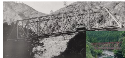
明神口橋(昭和4年完成の鋼製トラス橋) ★
