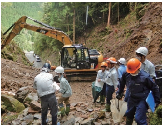
3日目: ICT施工の様子を見学
