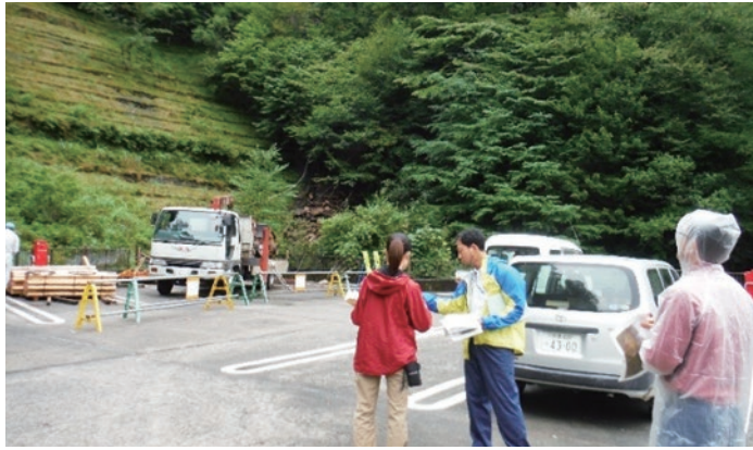
登山口駐車場で宮脇主任治山技術官より工事の説明
