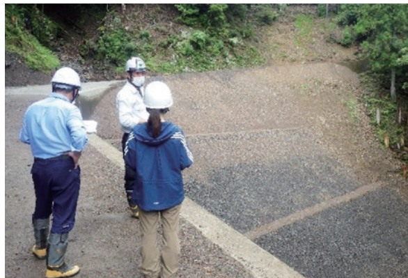
1日目：災害復旧工事についての説明
