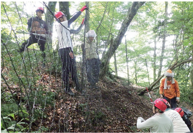
シカ防護網の修繕完了
