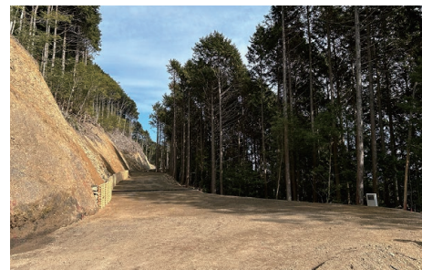
堂ヶ森林業専用道新設工事 (明許)
