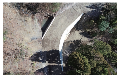
西川林道災害復旧工事 (明許)
