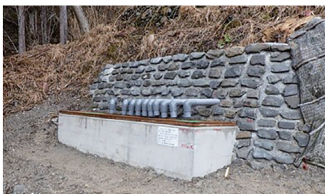
祖谷川地区麦生土(下)地すべり防止工事 (明許)
