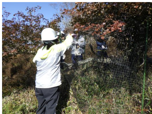
ラス巻き作業中
