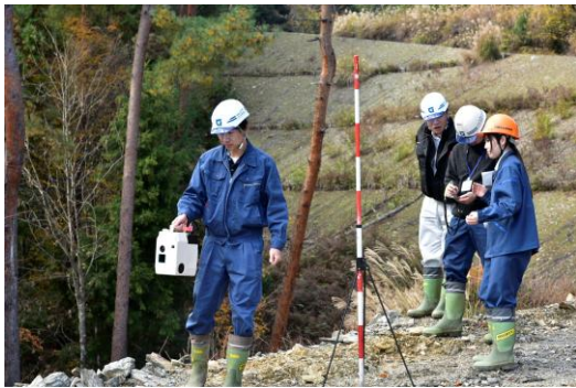
徳島県美馬市森林基幹道梶山内田線 ICT機器による計測状況 (R7. 11. 27)
