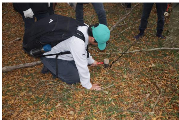
鹿防護網補修では最後にアンカーを確実に打ち込み作業完了！
