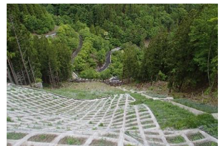
写真5 簡易吹付法枠工 参考
