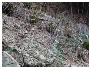
写真3 落石・崩土の堆積
