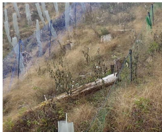
写真 17 青色ネット：防護柵（高さ 1.8m） 緑色ネット：防護柵（高さ 1.0m）
