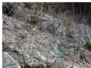
写真3 落石・崩土の堆積
