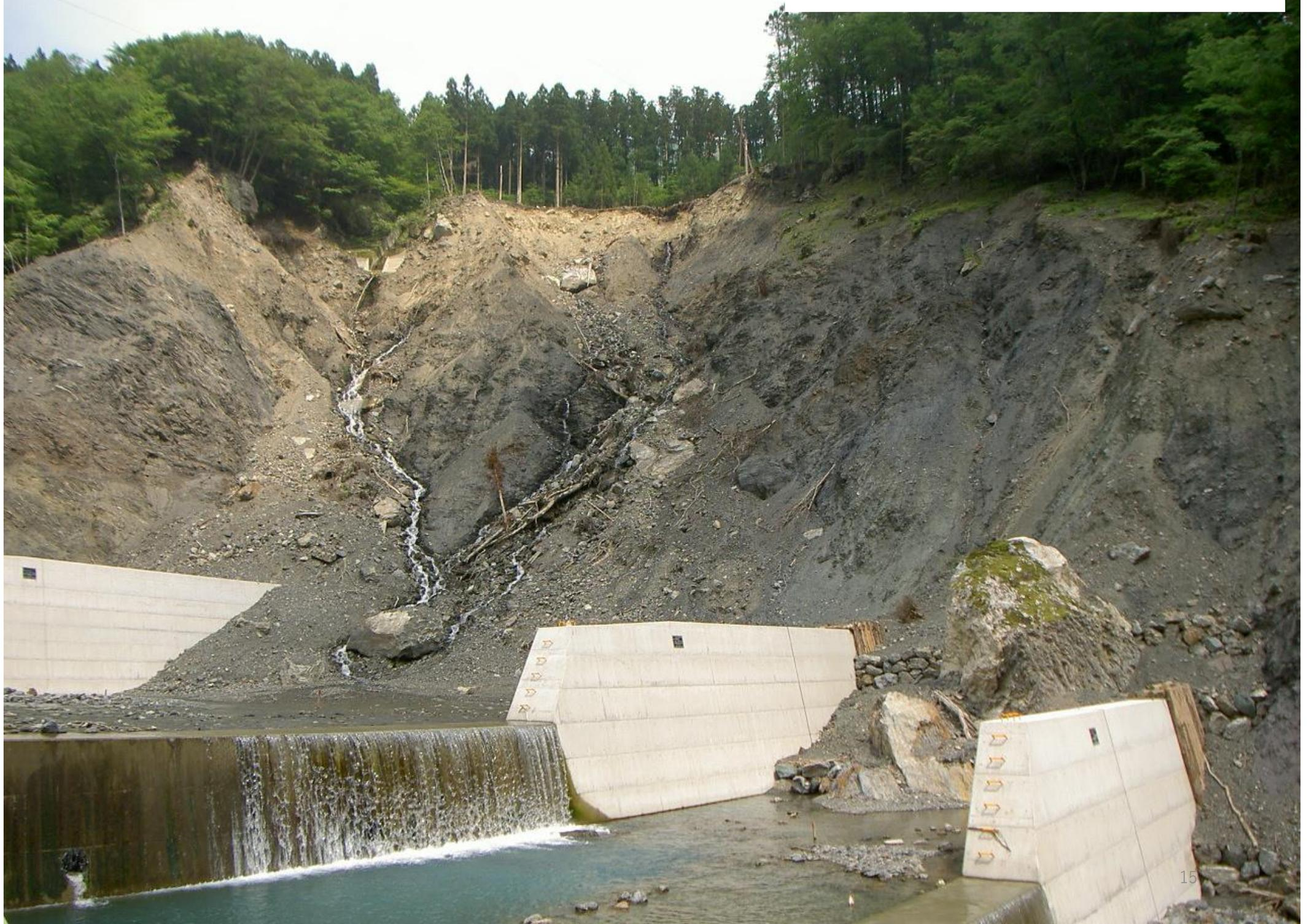
鋼製自在樁護岸工（完成後）
