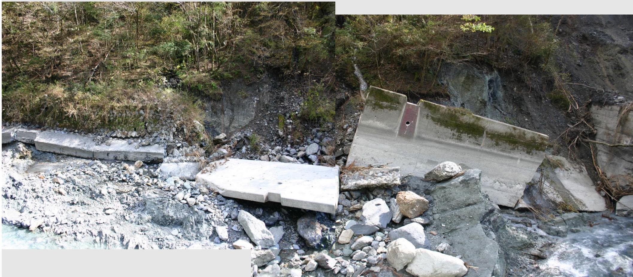
倒壊したコンクリート護岸工
