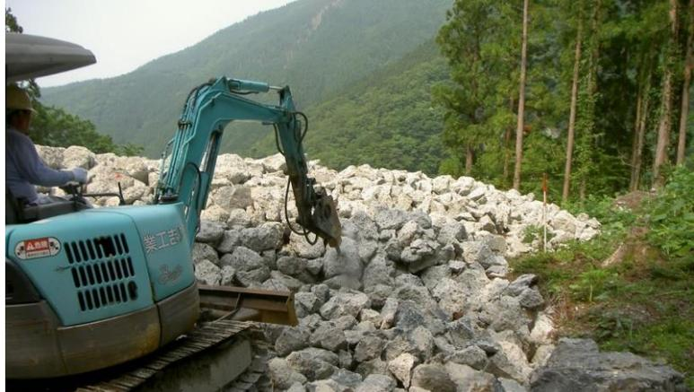
倒壊したコンクリートを細かく破砕
