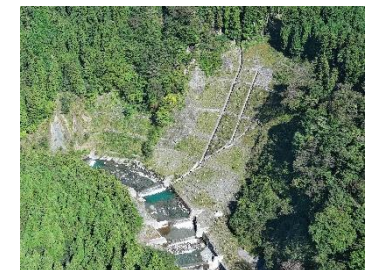
(写真 2：令和 6 年度 全景写真)
