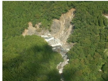
(写真 1：崩壊当初の状況)
