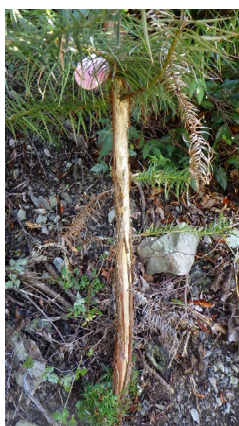
写真8 剥皮害があった主軸(軽度)※1
