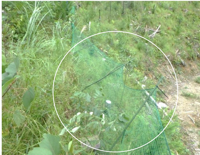
タイプE 支柱の破損
