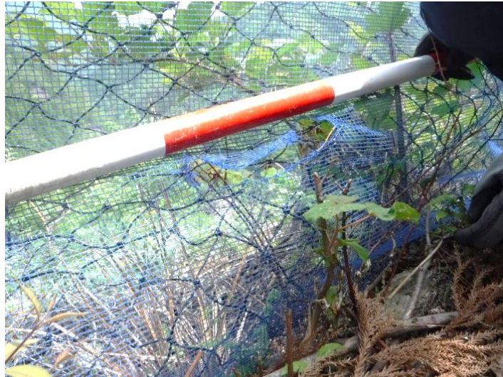
タイプA 防風用ネットの破損
