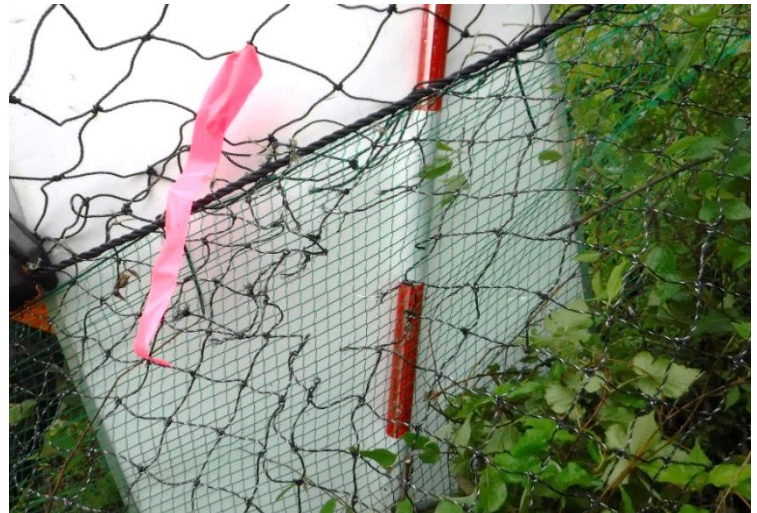
タイプB 本体ネットの破損
