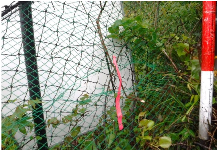
タイプB 市販ネット（スカート）の 破損
