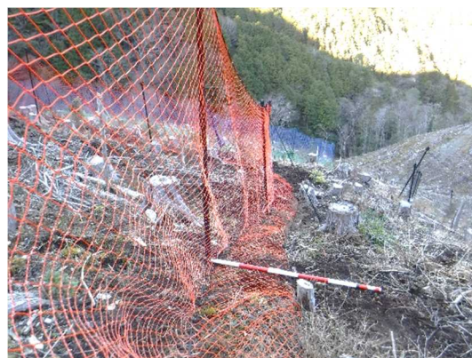
写真9 施工したL字型ネット
