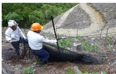
写真7 ネット引回し作業
